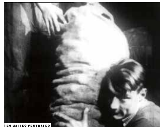
LES HALLES CENTRALES
